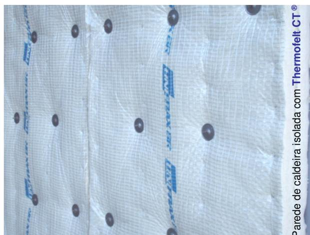
O sistema patenteado da **Thermofelt CT®** utiliza uma exclusiva proteção superficial entre a tela e a lã cerâmica, minimizando o contato do aplicador com a mesma e aumentando seu conforto na aplicação. Protege o isolamento contra intempéries em geral, bem como umidades, vapores, óleos e demais situações similares. Por estar protegido, o isolamento pode ser reutilizado, minimizando os custos de manutenção.
